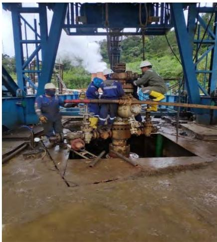
Gambar 3. Proses Penutupan Master Valve dan Side Valve pada Wellhead.
